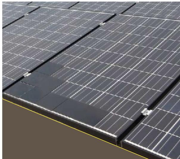
图1-6 4号和5号光伏阵列组件的遮挡示意图
