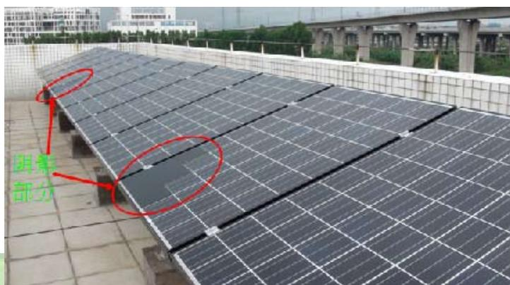
图1-5 2和3号阵列系统组件遮挡示意图
